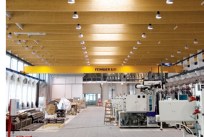
L’usine Playmobil de Diethofen en construction
